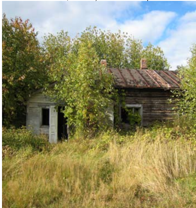
Niemen tilan rappeutunutta rakennuskantaa. (Oulunsalon yleiskaava-alueen rakennusinventointi, kohde 10). Rakennukset on purettu.
